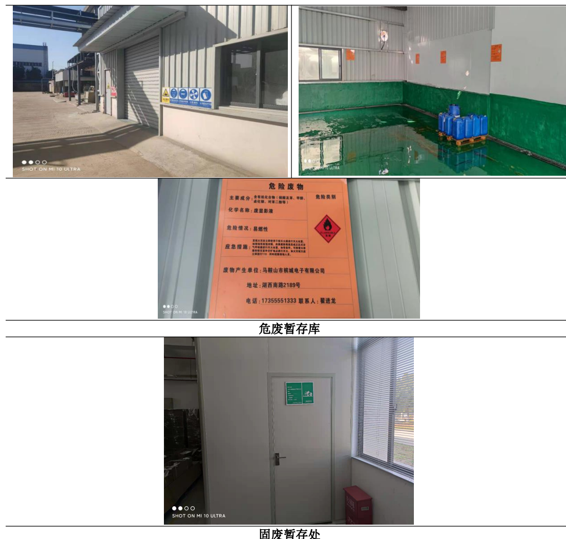
图 3-4 固体废物治理措施
